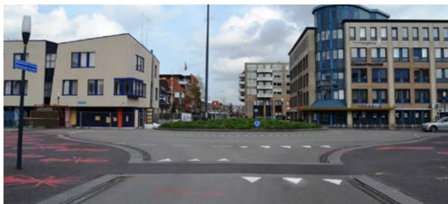
O mundialmente conhecido cruzamento "Laweiplein": semáforo substituído por rotatória elevada e supressão dos meios-fios
