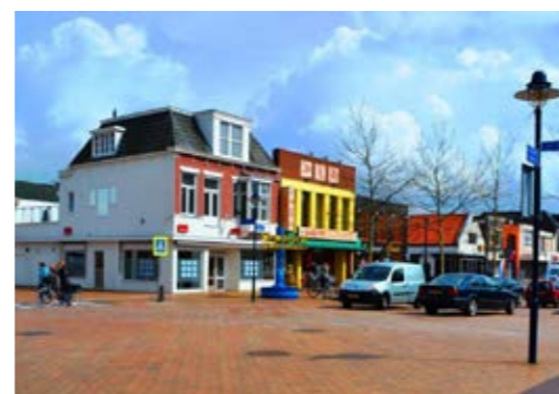
Pavimentação com peças de concreto intertravado substituiu o asfalto nas vias coletoras
